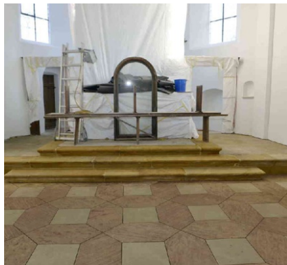
... und nach der Neuverlegung
