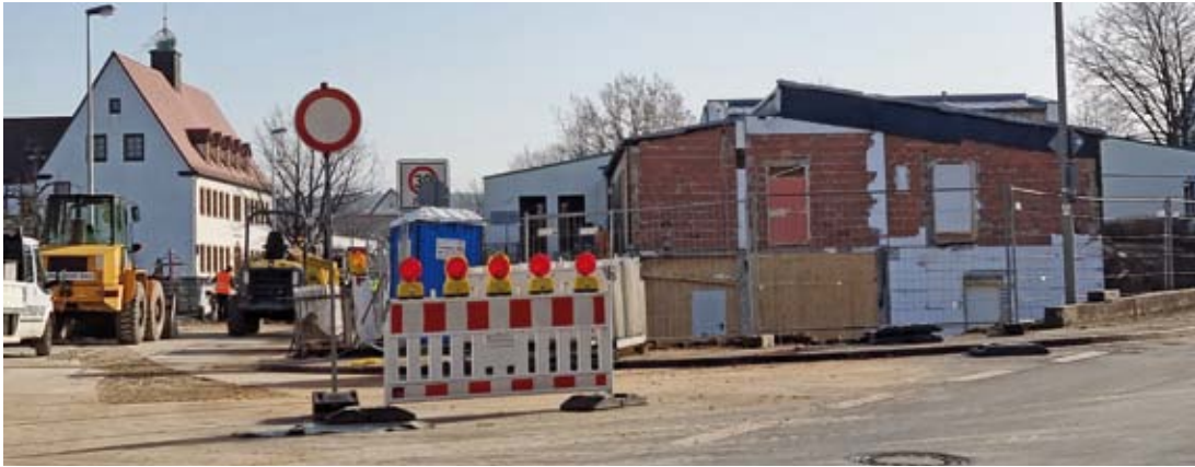
Die Abbrucharbeiten an der Kita St. Franziskus wurden im Februar durchgeführt.
